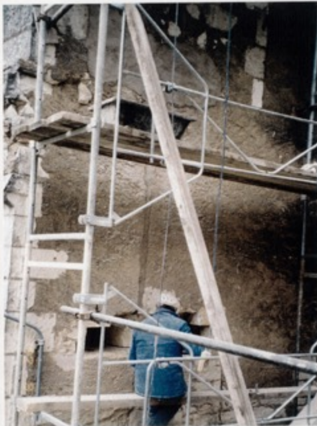
b) pendant et après les travaux
