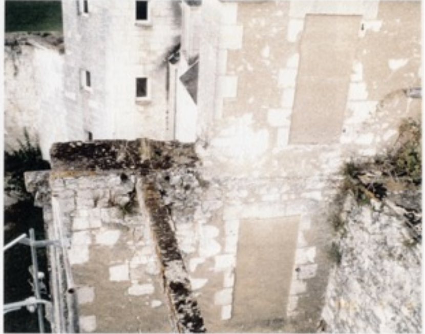
a) avant les travaux
